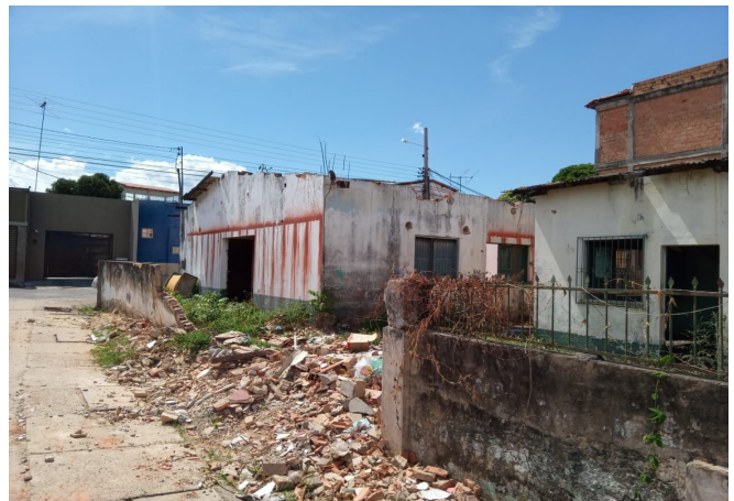
VISTA DO TERRENO
