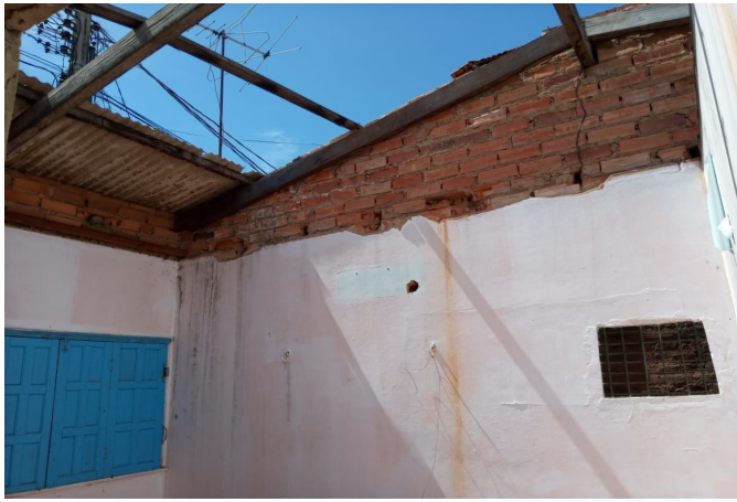
VISTA DO TERRENO
