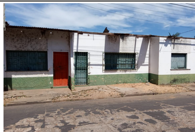
VISTA DO TERRENO
