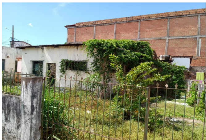
VISTA DO TERRENO
