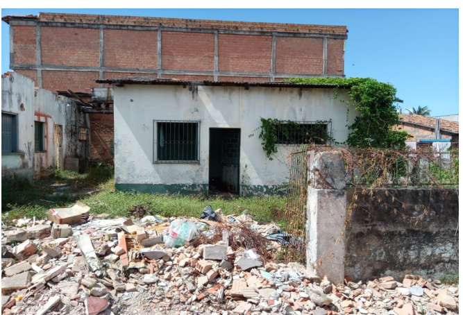
VISTA DO TERRENO
