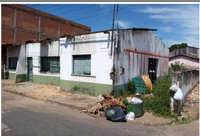
VISTA DO TERRENO
