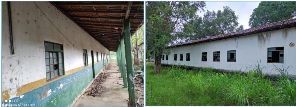
FOTO 01 E 02: Blocos existentes
