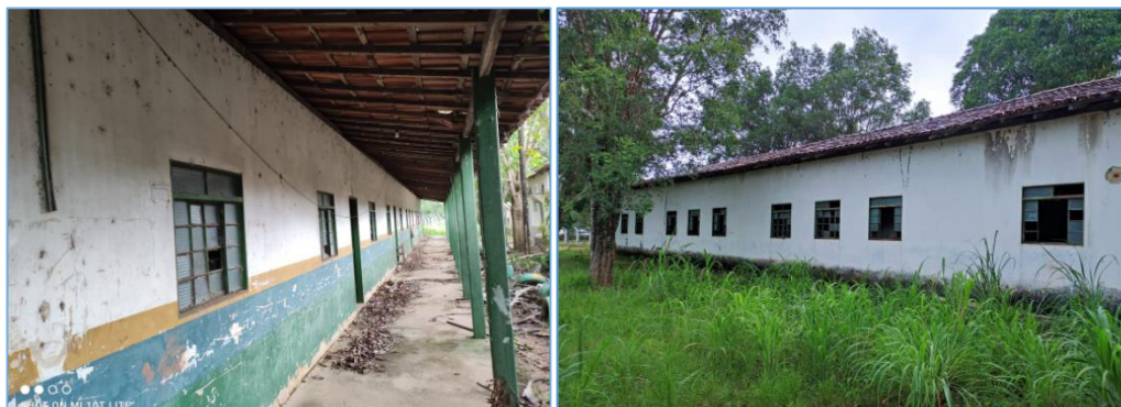
FOTO 01 E 02: Blocos existentes
