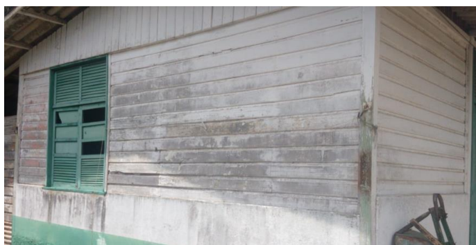
FOTO 11: ALMOXARIFADO – ESTADO DE CONSERVAÇÃO EXTERNA
