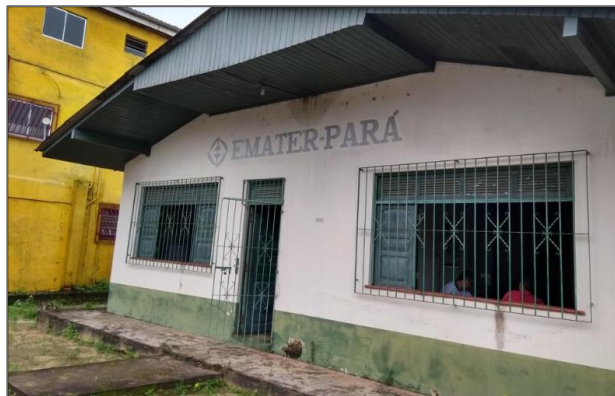
FOTO 01: ESTADO DE CONSERVAÇÃO DA FACHADA DO IMÓVEL
