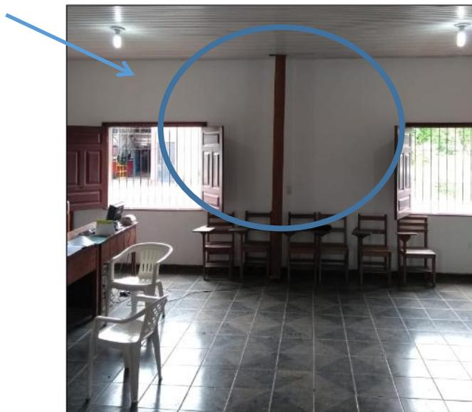
**FOTO 01: ESCORAMENTO PROVISÓRIO DA ESTRUTURA DO TELHADO**
