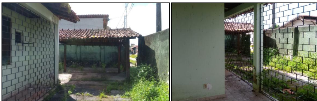
FOTO 01e 02: ESTADO DE CONSERVAÇÃO EXTERNA DO IMÓVEL
