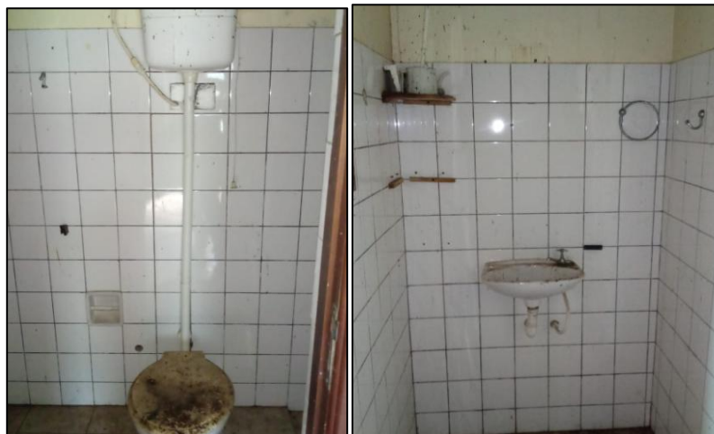
FOTO 05 E 06 : INSTALAÇÕES HIDRÁULICAS EXISTENTES
