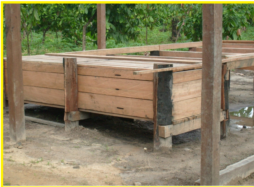
Figura 6 - Assoalho suspenso central sobre o cocho de fermentação. Fonte: Acervo EMATER-PARÁ
