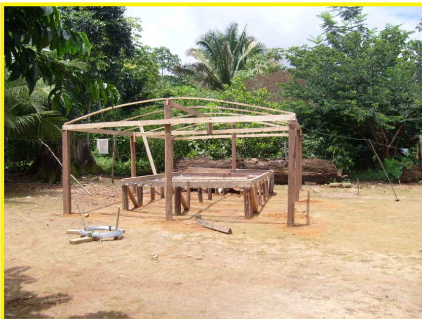
Figura 3 - Estrutura de madeira de lei, tipo galpão (estufa)
