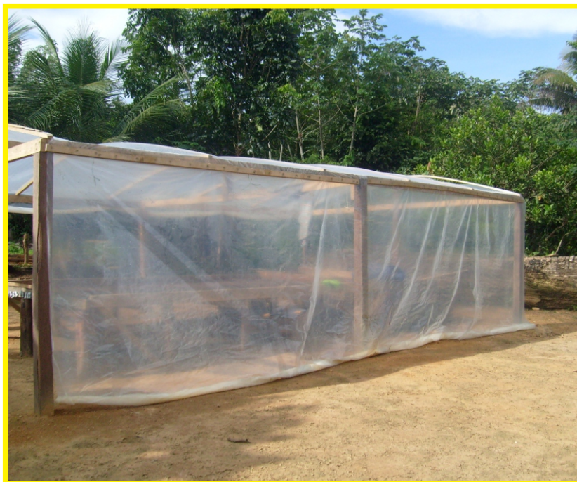
Figura 5 - Vista da estufa com as laterais móveis estendidas
