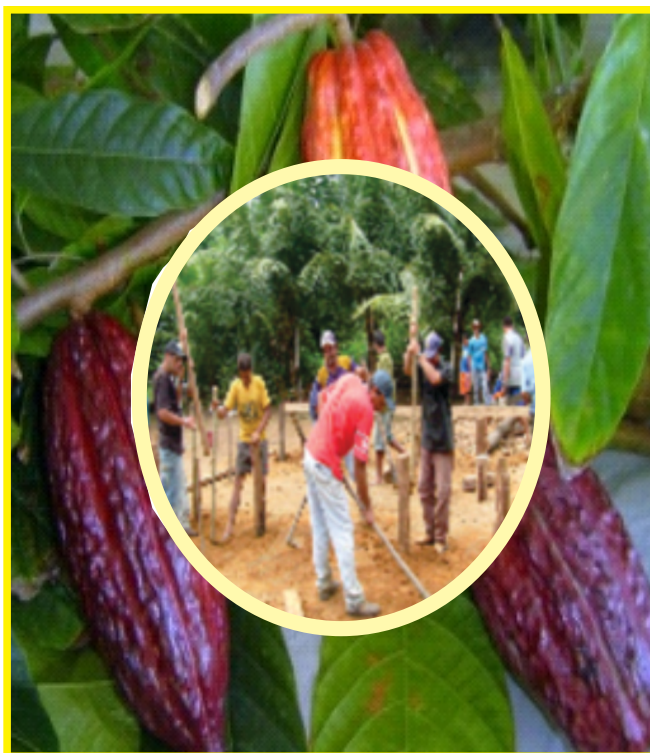
Figura 2 - Preparo da área para instalação da estufa de secagem
